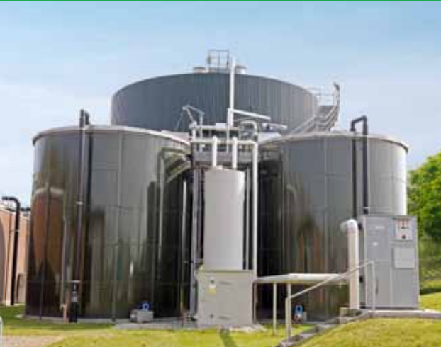
Faulung der Kläranlage in Emmerich
